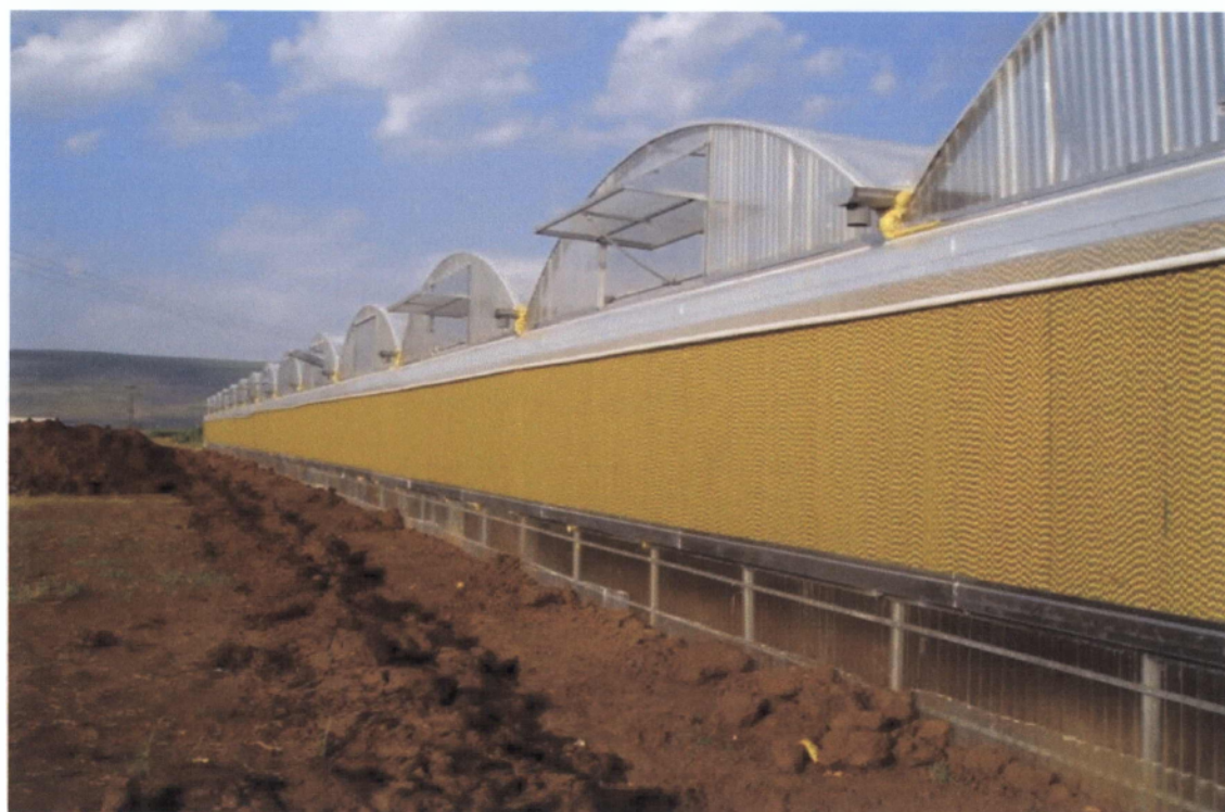
Εικόνα 18. Σύστημα Υγρών Πετασμάτων, Πάνελ
