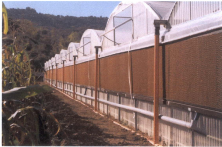
Εικόνα 19. Σύστημα Υγρών Πετασμάτων
