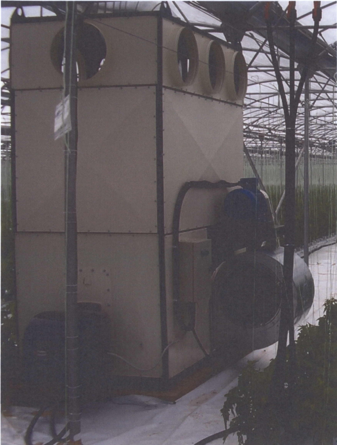
Εικόνα 23. Αερόθερμα
