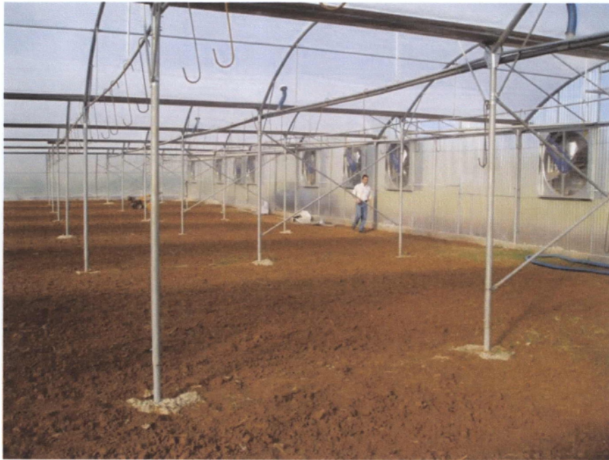
Εικόνα 15. Εξαεριστήρες
