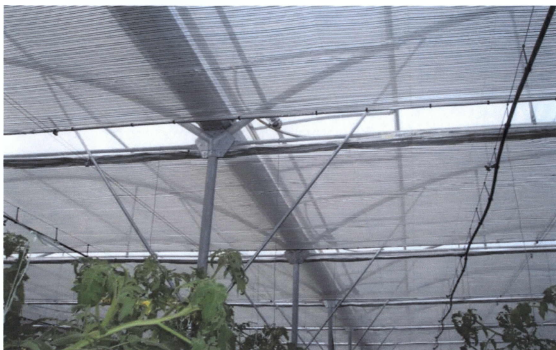
Εικόνα 9. Κουρτίνες σκίασης
