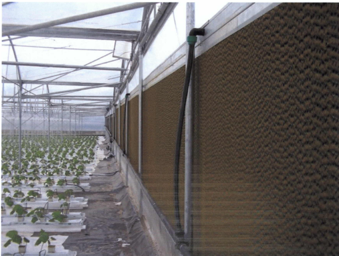
Εικόνα 20. Σύστημα Υγρών Πετασμάτων
