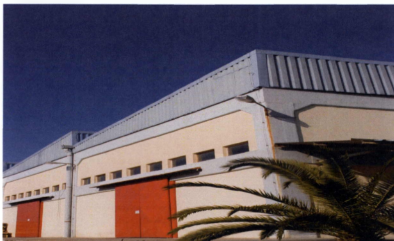
Εικόνα 9: Πρόσοψη μέρους κτιρίου «ΣΥΚΙΚΗΣ»
