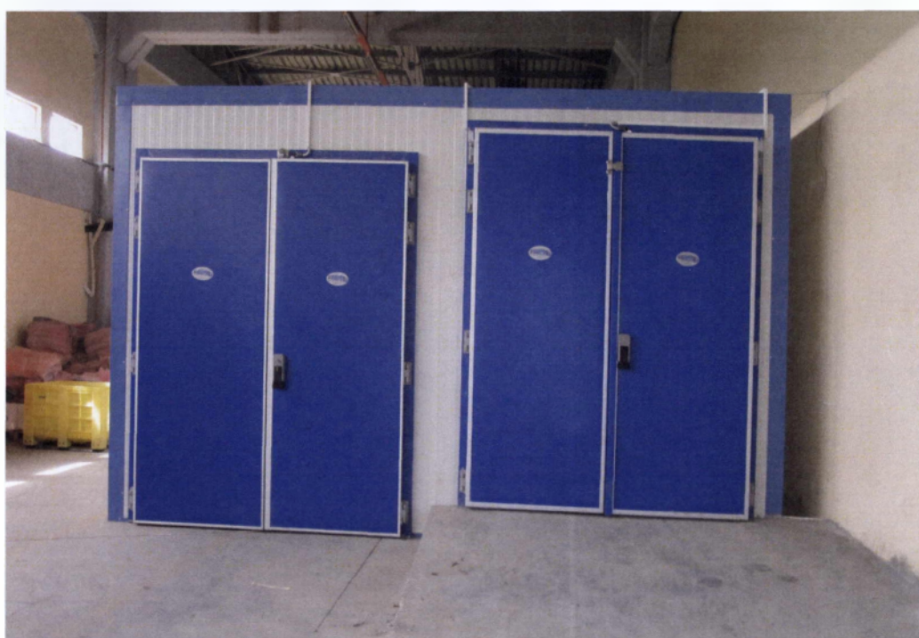
Εικόνα 13: Καταψύκτες για απεντόμωση των βιολογικών σύκων στους -18^{\circ}\text{C} .
