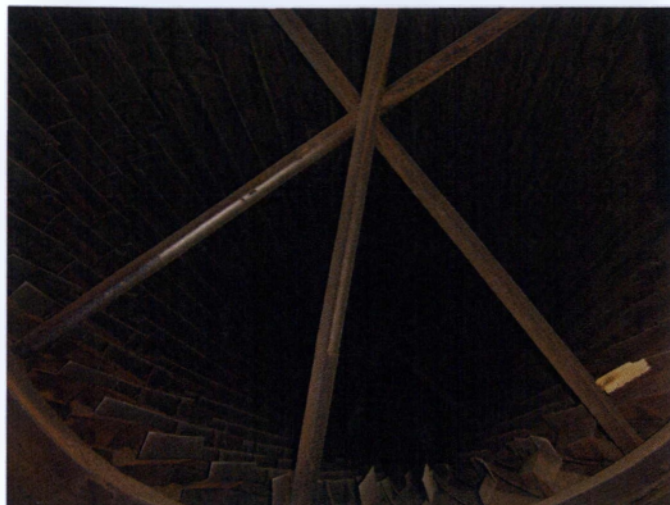
Εικόνα 45: Εσωτερικό ξηραντηρίου συνεχούς λειτουργίας στο εργοστάσιο ΠΥΡΗΝΑΣ ALFA Α.Ε. στην Καλαμάτα
