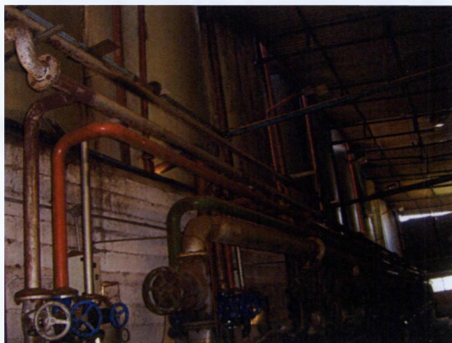
Εικόνα 46: Συσκευή διακεκομμένης εκχυλίσεως στο εργοστάσιο ΠΥΡΗΝΑΣ ALFA A.E. στην Καλαμάτα
