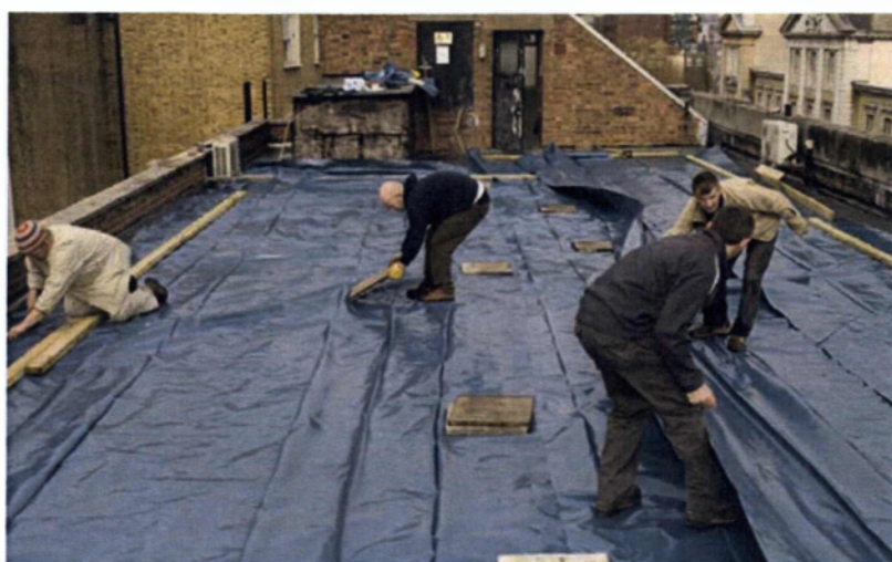
ΕΙΚΟΝΑ 14 ΤΟΠΟΘΕΤΗΣΗ ΑΔΙΑΒΡΟΧΗΣ ΜΕΜΒΡΑΝΗΣ
