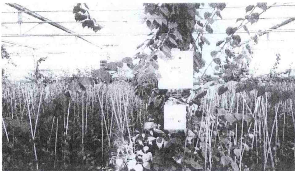
Εικόνα . Ηλεκτρονικό σύστημα καταγραφής και ρύθμισης μερικών παραγόντων περιβάλλοντος του θερμοκηπίου. α)θερμοστάτης β)κλίση παραθύρων γ)ρυθμιστής βροχής δ)ρυθμιστής ανέμου
