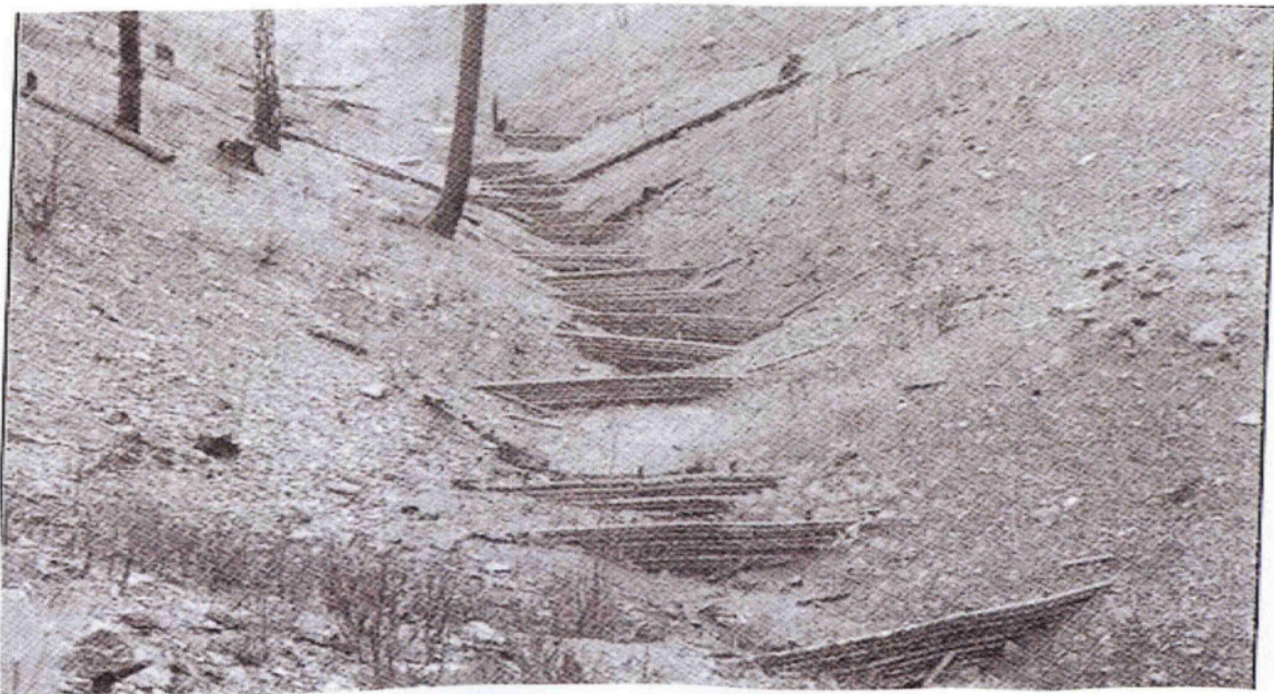
Εικόνα 13. Σειρά ξυλοφραγμάτων στο δάσος Ταΰγετου.
