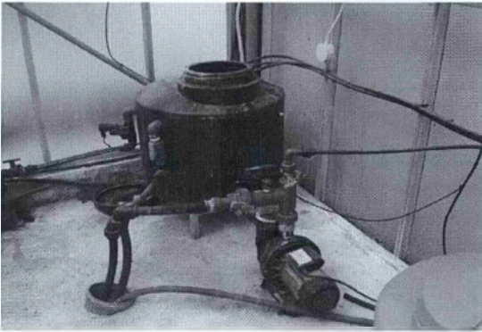
Εικόνα 6: Δεξαμενή συλλογής θρεπτικού διαλύματος
