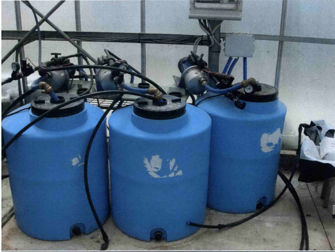
Εικόνα 6. Δοχεία θρεπτικών διαλυμάτων αυτομάτου ποτίσματος
