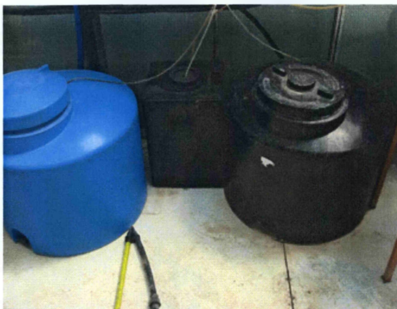
Εικόνα 16: δεξαμενές πυκνών διαλυμάτων και οξό.
