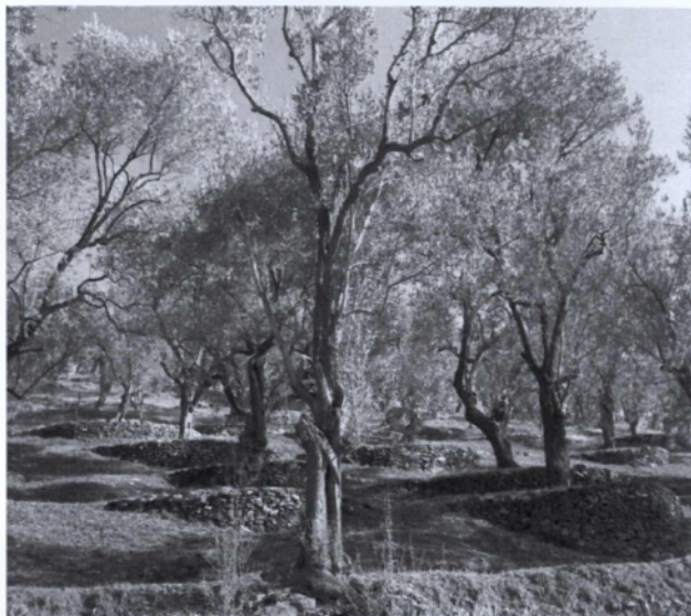
Εικ. 4.4 Ξηρολιθοδομική κατασκευή ατομικών αναβαθμίδων
