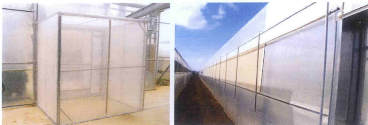
Εικόνες 14, 15: Εγκατάσταση προθαλάμου με διπλές πόρτες στα θερμοκήπια (αριστερά) και το εντομοστεγές δίκτυο (δεξιά).
