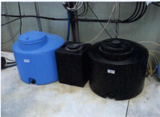
Εικόνα 8: Δεξαμενές πυκνών διαλυμάτων
