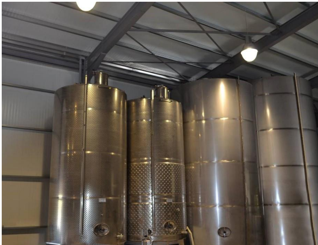
Εικόνα 12 Δεξαμενές αποθήκευσης ελαιόλαδου (OLYMPIAN GREEN)
