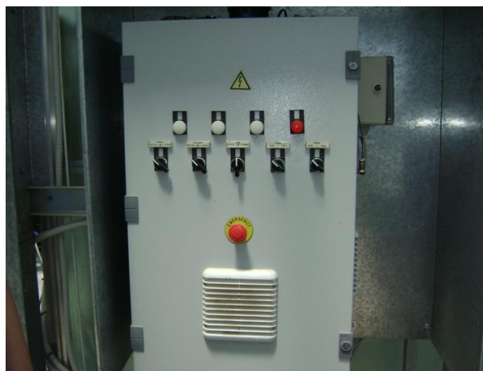
Εικόνα 21: Ηλεκτρικός πίνακας, ελέγχου λειτουργίας floating, υδρονέφωσης και ανεμιστήρων.
