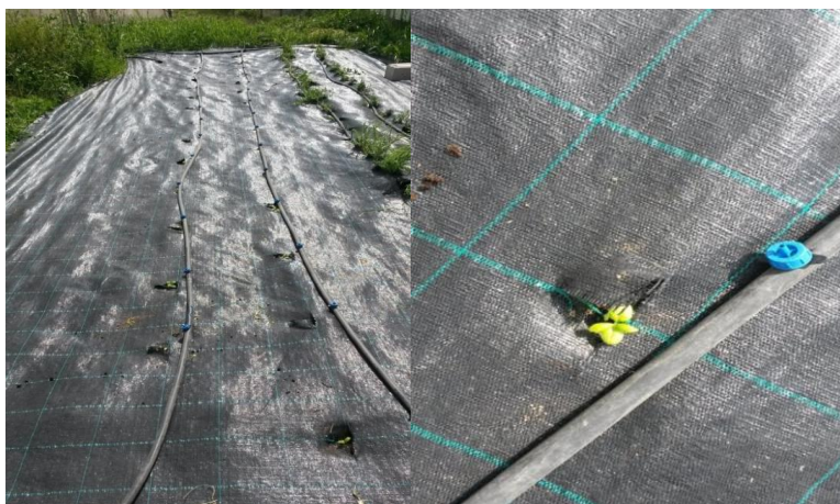
Εικόνα 38: Τοποθέτηση γεωφάσματος και αρδευτικού συστήματος
