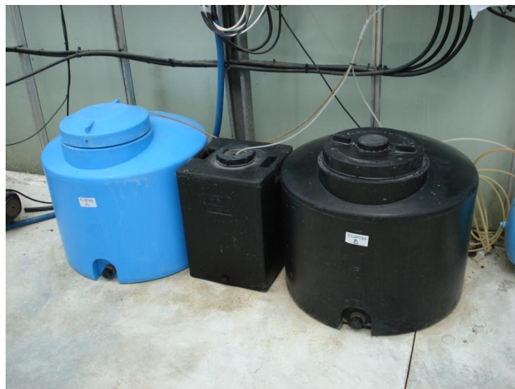
Εικόνα 25: Δεξαμενές πυκνών διαλυμάτων
