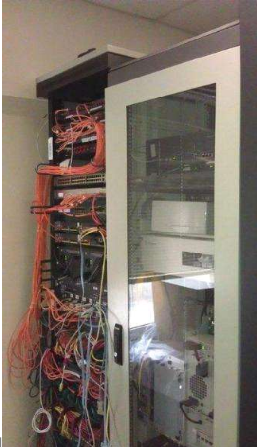
Εικόνα 16: Κεντρικό switch Π.Γ.Ν.Π.
