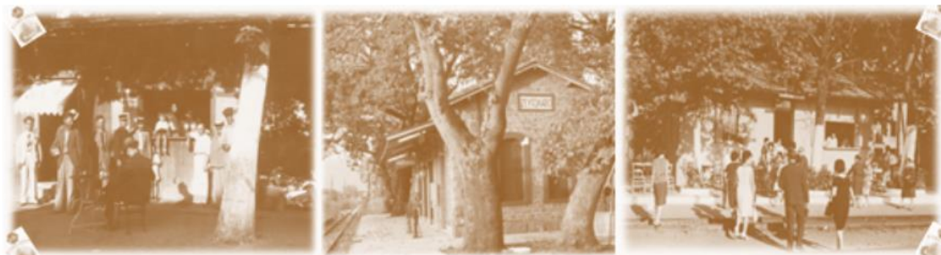
Εικόνα 6: Θέση του πρώτου εργαστηρίου παρασκευής παστελιού στο Ζευγολατιό Μεσσηνίας ( http://www.evmelin.gr )
