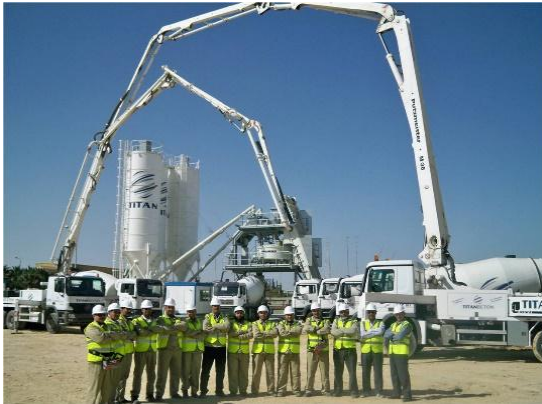
Μονάδα Παραγωγής ετοιμού σκυροδέματος, Borg El-Arab, Αλεξάνδρεια
