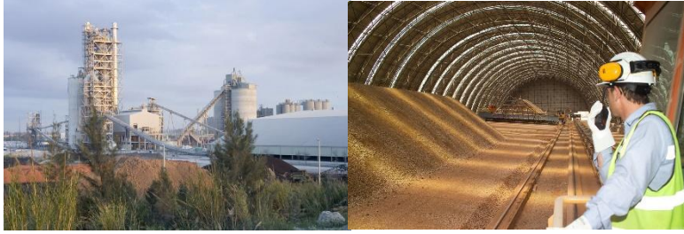
Εργοστάσιο Τσιμέντου, ANTEA, Αλβανία
