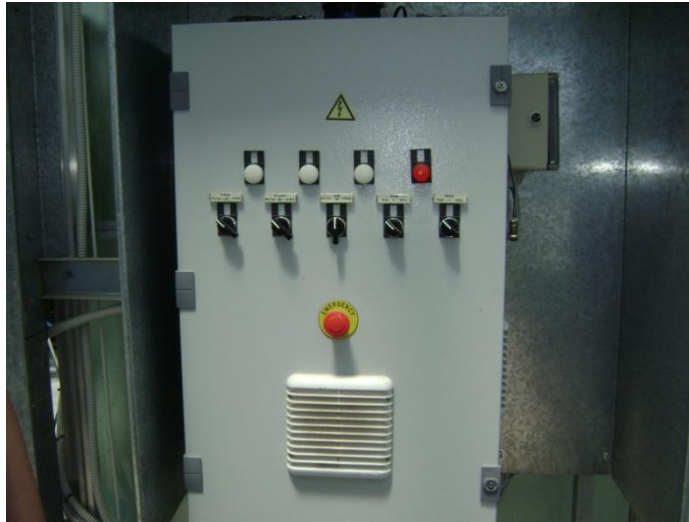
Εικόνα 13. Ηλεκτρικός πίνακας, ελέγχου λειτουργίας floating, υδρονέφωσης και ανεμιστήρων.
