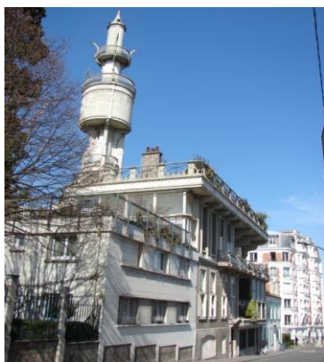
Εικόνα 1-19: Francois Hennebique 1894-1904, η πρώτη στέγη από σκυρόδεμα στη Γαλλία (Πηγή: www.wikipedia.com )
