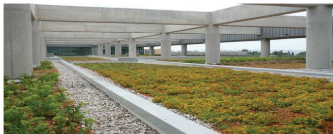
Εικόνα 2-1: Φυτεμένο δώμα εκτατικού τύπου στο Νέο Κτίριο της Τράπεζας της Ελλάδος στη Θεσσαλονίκη (Πηγή: www.econ3.gr )
