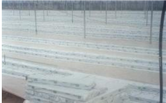
Εικόνα 3.7: Εγκατάσταση υποστρώματος πετροβάμβακα
