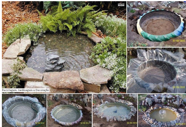
Εικόνα 23. Κατασκευή λίμνης από λάστιχο μεγάλου οχήματος ( www.inlandscapes.com )
