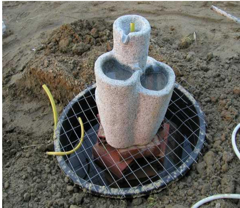
Εικόνα 26 Κατασκευή σιντριβανιού πριν καλυφθεί η δεξαμενή με ανόργανα υλικά ( www.pangea.gr )
