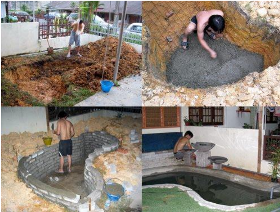
Εικόνα 21. Κατασκευή λίμνης από σκυρόδεμα (Noordhuis, 2006)
