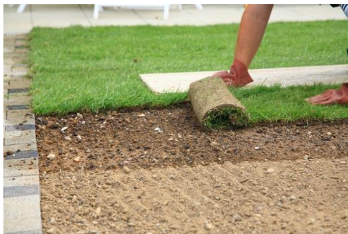
Εικόνα 56. Εγκατάσταση έτοιμου χλοοτάπητα σε ρολό (διαδίκτυο 78)
