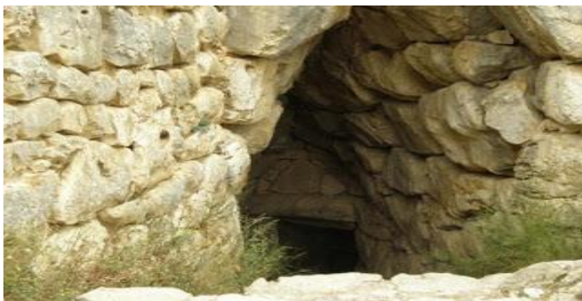
Εικόνα για την είσοδο της υπόγειας δεξαμενής
